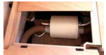
Fast an der Heckwand befindet sich die Truma Therme mit den Anlassventilen
